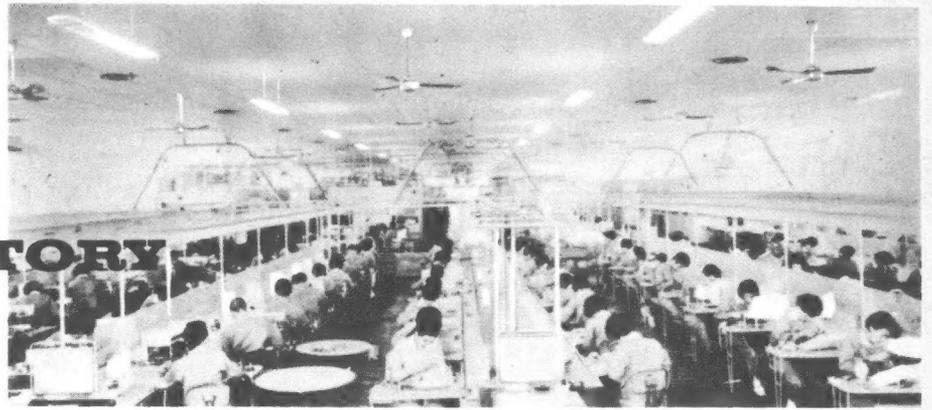
2.500.000 NATIONAL-Radios produziert Matsushita Electric in einem Jahr. Damit ist Matsushita Electric der größte Radio-Hersteller der Welt. Unser Bild zeigt die langen Fließbänder, an denen ausgebildete Facharbeiterinnen Transistor-Radios herstellen.
